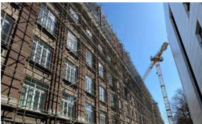
Travaux de surélévation du bâtiment U
